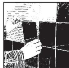
Le piastrelle da muro possono essere incollate sul Climaform utilizzando un adesivo in dispersione per piastrelle. Dopo una settimana di asciugatura si possono chiudere le giunture fra le piastrelle.
